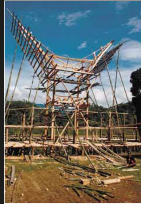
A sinistra l'interno di una casa farfalla ultimata nel villaggio di Noh Bo. Nelle immagini in sequenza tre particolari delle case della tribù dei Toraja che si trovano nell'isola indonesiana di Sulawesi, con struttura portante in legno e copertura di bambù.
